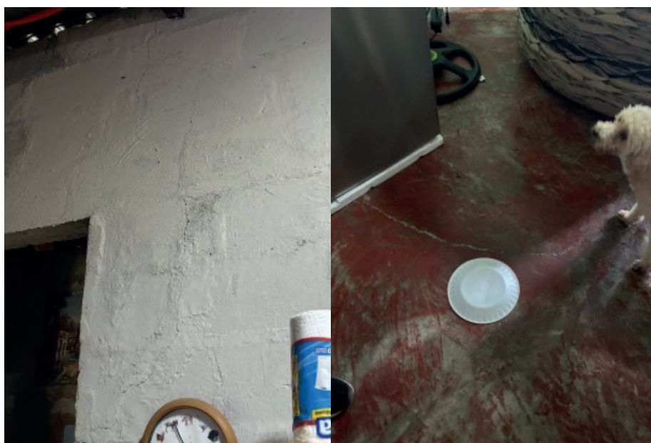
Imagen 5: Viviendas con grietas por asentamientos diferenciales
