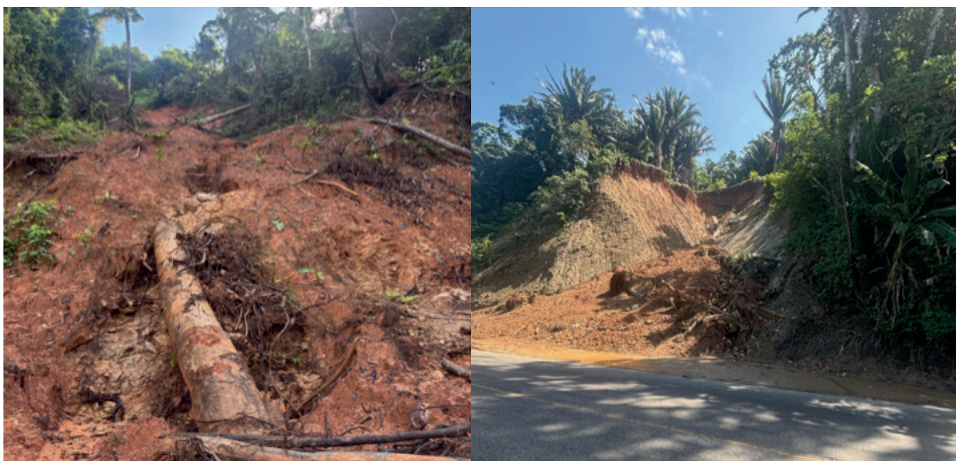
Imagen 15: Deslizamientos de suelo que afectaron caminos
